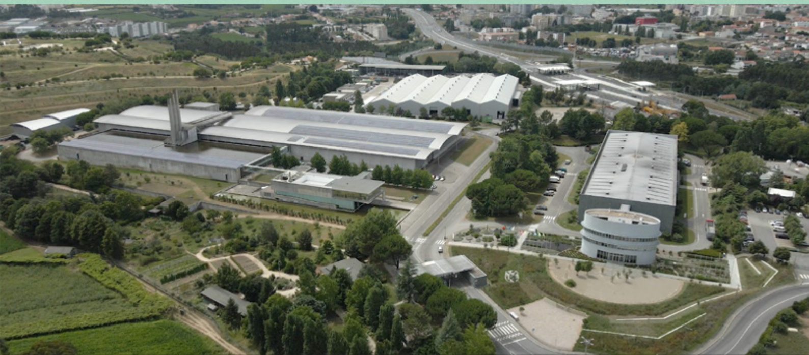
Fig. 4 - Instalações da Lipor (Centro de Triagem, Central de Compostagem e Parque Aventura)
