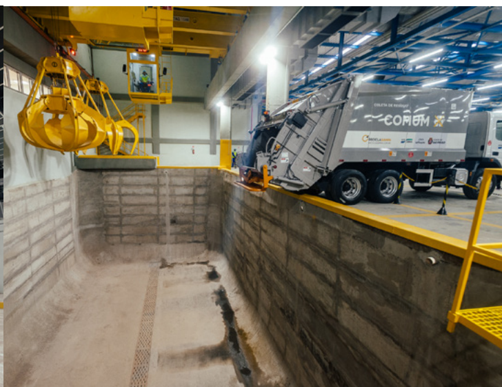
Os caminhões compactadores descarregam os resíduos diretamente em carretas, por meio do uso de uma bica, ou então em um fosso, com o material sendo transbordado posteriormente com a ponte rolante
