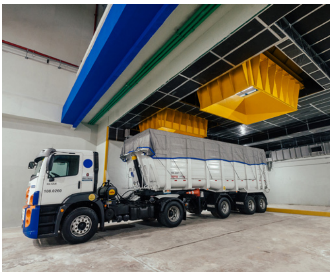
Os caminhões compactadores descarregam os resíduos diretamente em carretas, por meio do uso de uma bica, ou então em um fosso, com o material sendo transbordado posteriormente com a ponte rolante
