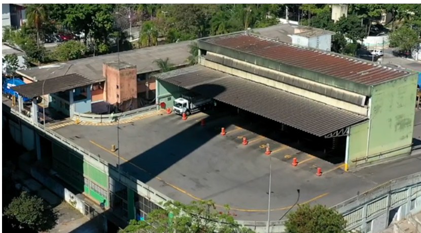
Pátio de manobras dos caminhões compactadores. À direita, cobertos pelo telhado, estão as bicas e o fosso
