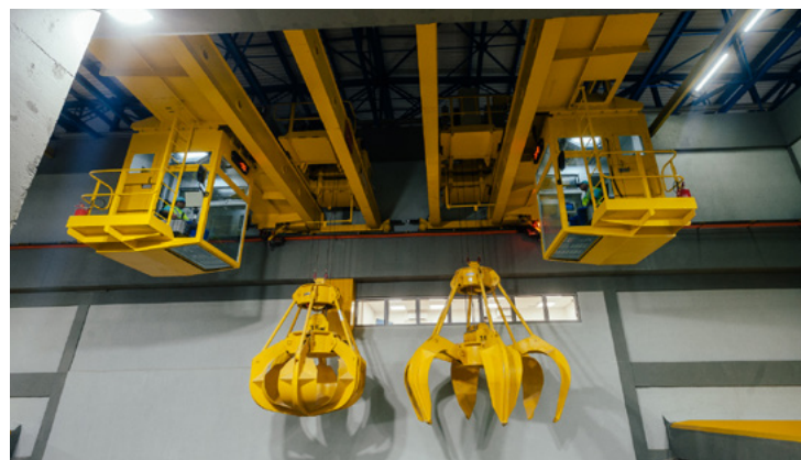
Detalhe da ponte rolante
