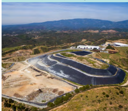
Vista aérea de aterro sanitário em Faro, região do Algarve
