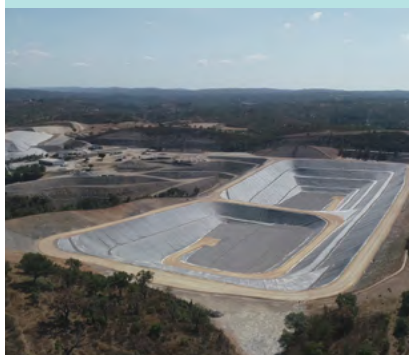
Célula do aterro sanitário em Sotavento, na região do Algarve, operado pela Algar.
