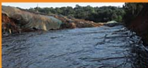
Ampliação do Aterro Sanitário da Caximba em Curitiba / PR.
